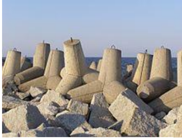
Figura 9. Tetrapodi utilizzati come frangiflutti
